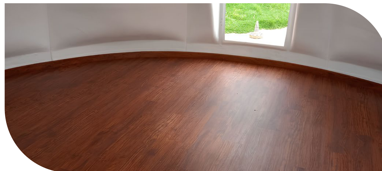
Piso SPC, impermeable, tráfico medio.
